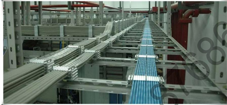
高压电缆是楼宇供电系统的主要线路，电流大，发热量高，加上高压电缆在竖井、母线槽内处于密封状态，不易散热，极易发生局部过热现象，严重时电缆绝缘失效，可能造成电缆被击穿突然断电，影响楼宇内正常生产生活。电缆竖井与母线槽网状分布于高层楼宇的各个楼层，一旦发生火灾，由于现代建筑房间密闭性比较好，难以被发现；楼宇内易燃材料多，火势蔓延迅速；高层楼宇逃生困难等原因，会严重危及楼内人员生命和财产安全。
